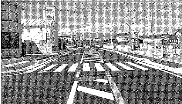
国道141号電線共同溝工事(明許)
