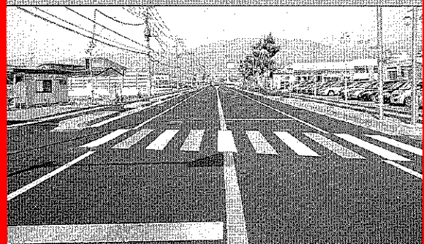
(都)相生一丁目飯喰線電線共同溝工事3工区(明許)
