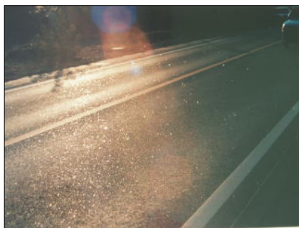
「キララスコン」で施工した県道。廃ガラスの有効利用により、道路の視認性を高め、安全性に寄与する。
